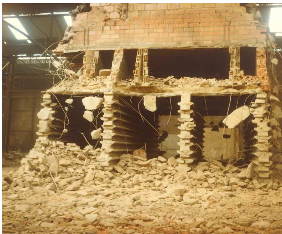
Des chanbres ou séchoirs en cours de démolition.
